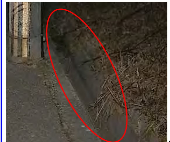
道路と側溝が明確になった
