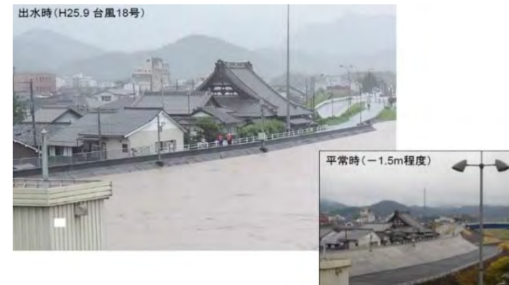
平成25年台風18号のときの福知山市街付近の堤防の様子 家の2階に相当する高さまで水位が上昇し、堤防が決壊寸前。
