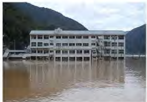
H26.8避難所2階の浸水(徳島県)
