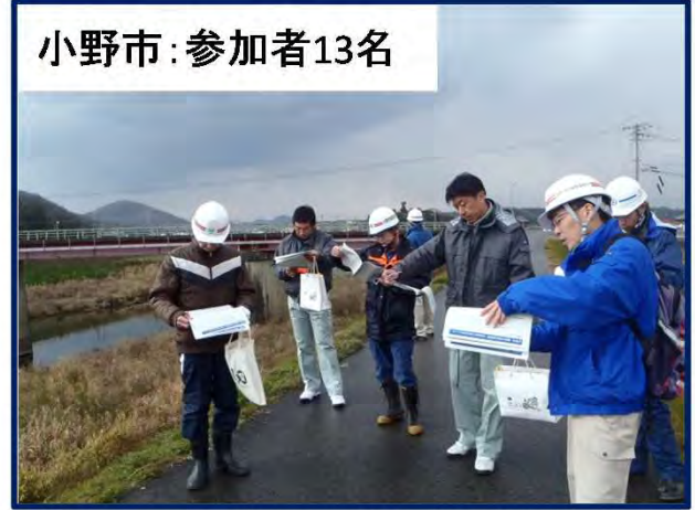
万願寺川左岸0.2k付近 (堤防断面)
