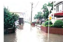
高砂市の浸水状況
