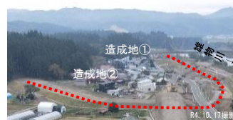
移転家屋の建設が進む状況
