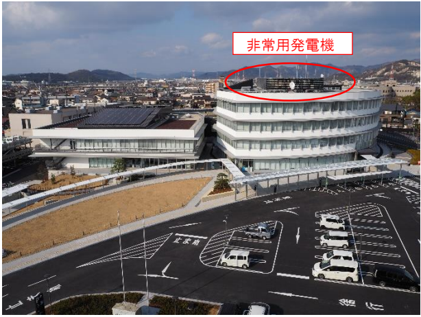
電気設備の高所配置
