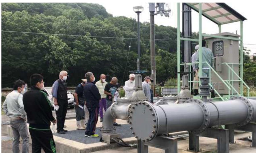
福地雨水ポンプ場で試運転
