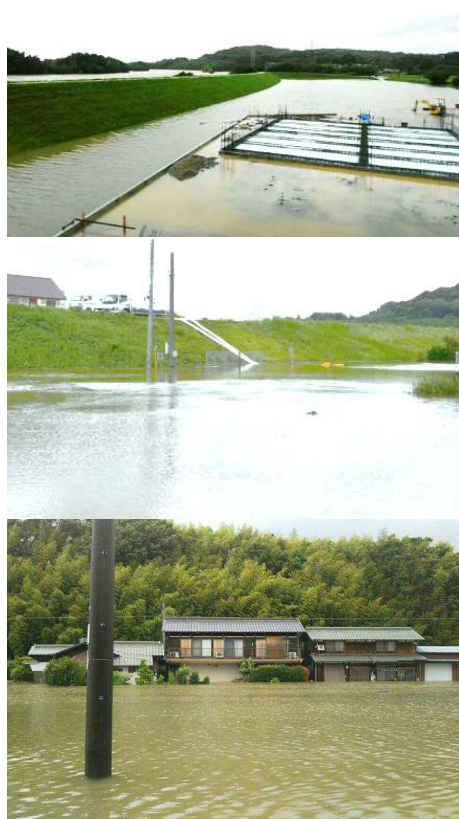
【過去の被災状況】
