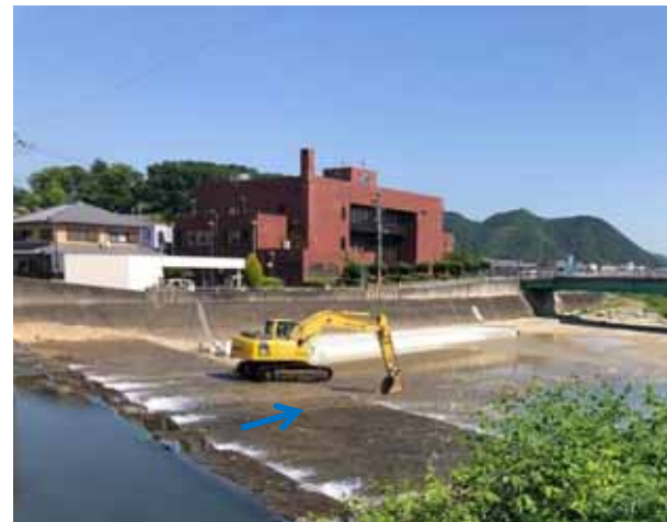
沖田井堰(H31.1工事着手)
