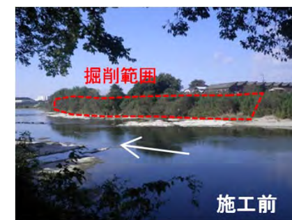
掘削事業 施工状況(加古川33.8k付近)
