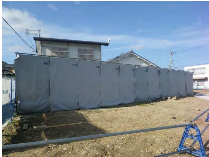
騒音対策(防音シート)
