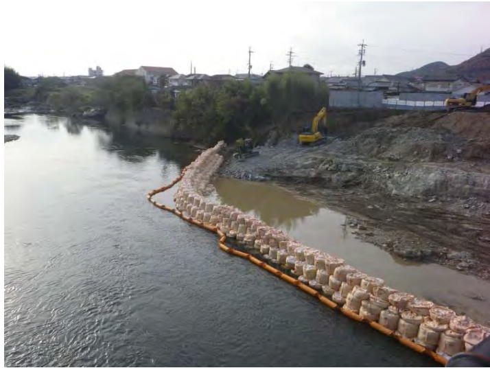
濁水対策(シルトフェンス)
