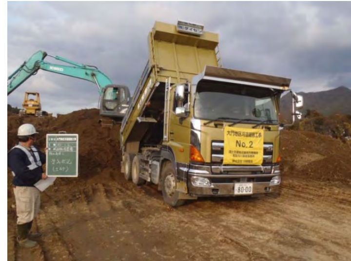
関連工事受入状況(西脇北バイパス)
