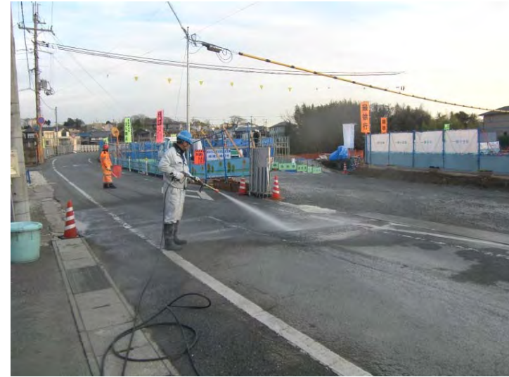
粉塵対策(散水)
