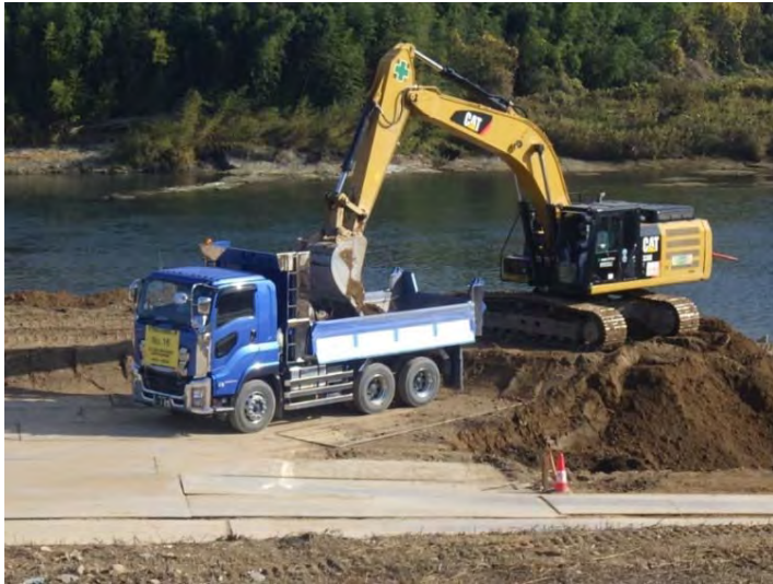
掘削残土搬出状況
