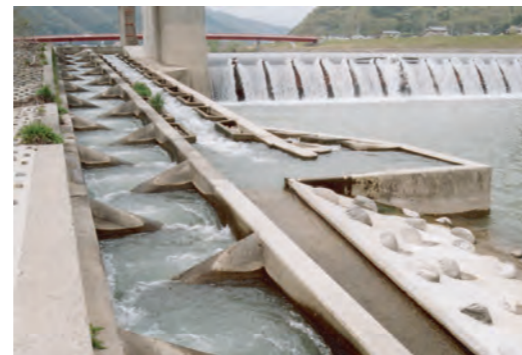
吉島統合頭首工の魚道
