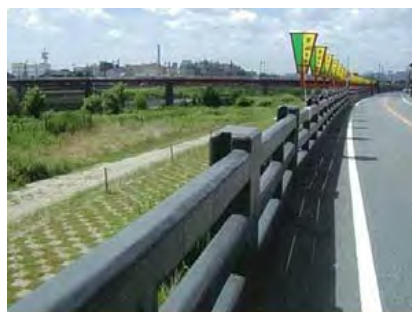
図-2.3.17 畳堤(たつの市旭橋付近)
