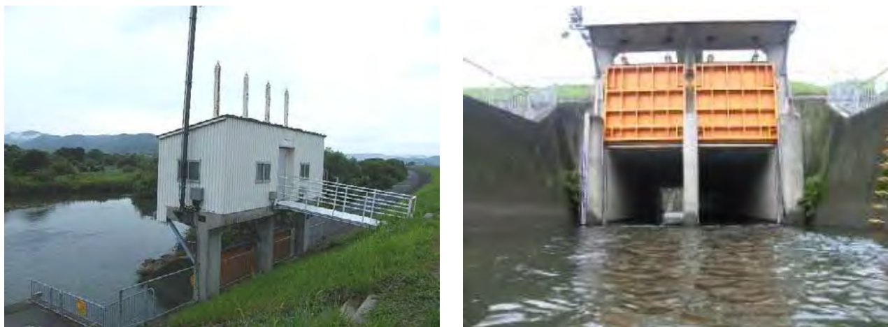
図-2.1.8 排水樋門(真砂排水樋門)
