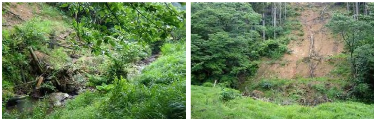
図-2.1.2 山林荒廃による土砂災害(支川 高野川)
