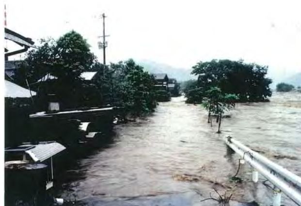
宍粟橋右岸浸水状況(宍粟市山崎町)
