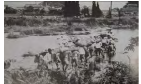
図-1.3.1 井堰設置の様子 (昭和32年:片吹井堰)
