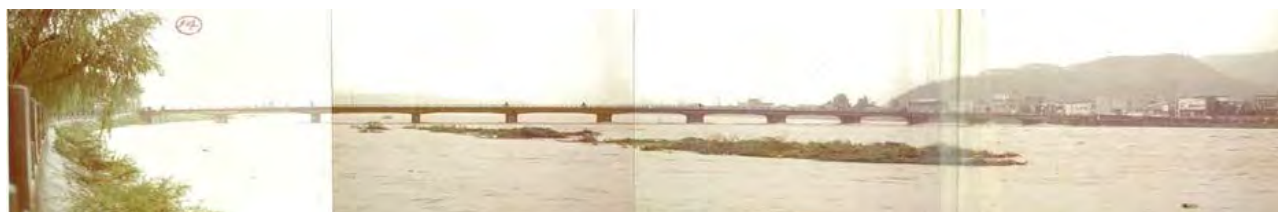
洪水中の龍野橋の状況(たつの市)
