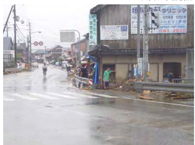
安積橋下流浸水状況(宍粟市一宮町)
