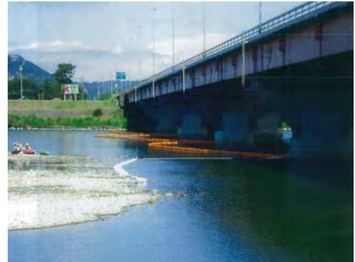
図-3.5.1 水質事故対応(オイルフェンス)
