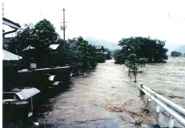
宍粟橋右岸浸水状況(宍粟市山崎町)
