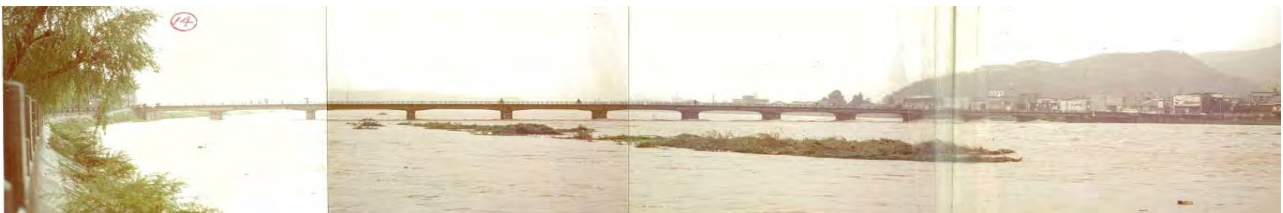
洪水中の龍野橋の状況(たつの市)
