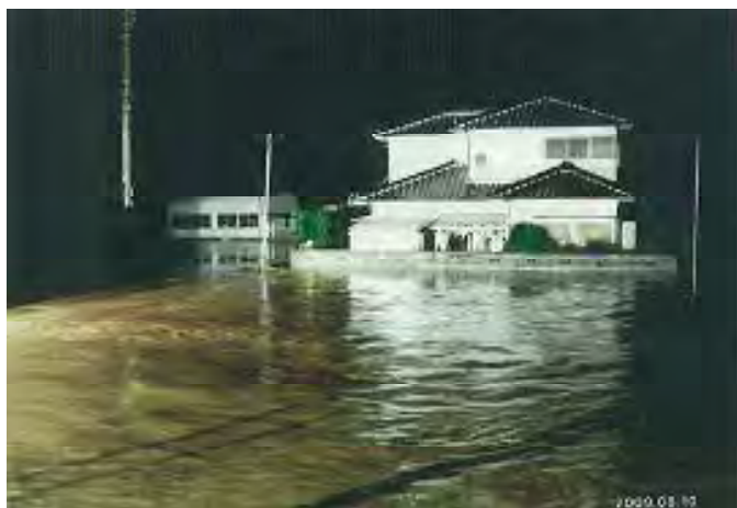
野田橋下流浸水状況(宍粟市山崎町)
