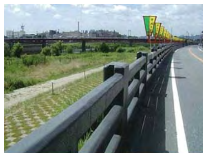
図-2.3.17 畳堤(たつの市旭橋付近)
