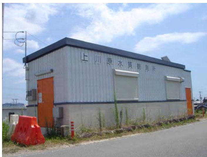
図-2.3.12 上川原水質自動観測所
