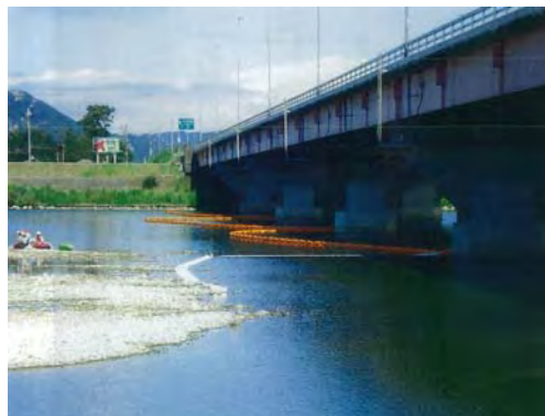
図-3.5.1 水質事故対応(オイルフェンス)
