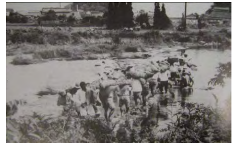
図-1.3.1 井堰設置の様子 (昭和32年:片吹井堰)
