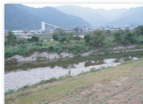
堤防上より上流方向
