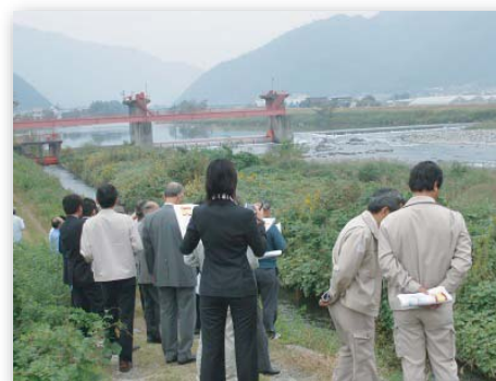
河東大橋より上流方向
