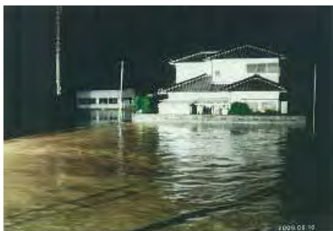
野田橋下流浸水状況(宍粟市山崎町)
