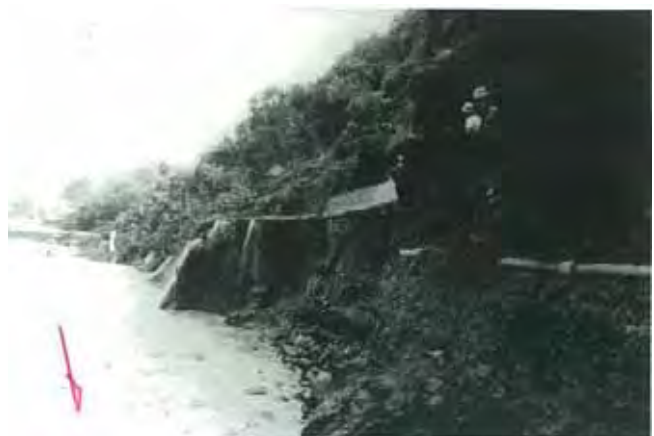
揖保川が氾濫し流失した県道 6 号線(曲里付近)
