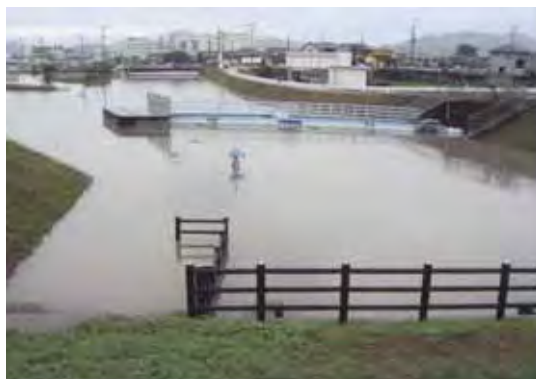
図-2.1.12 平成 16 年 9 月 台風 21 号による蟠洞川内水状況(姫路市余部区下余部)
