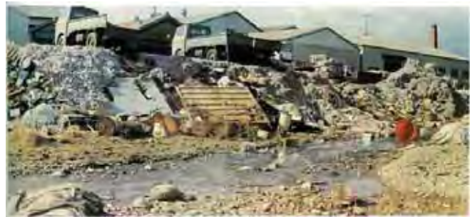
図-2.3.9 昭和50年代の林田川山陽本線橋梁付近
