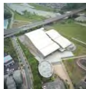
図-2.4.3 揖保川防災ステーション
