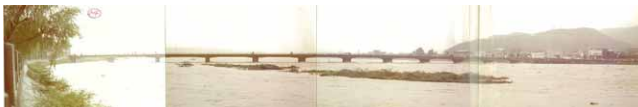
洪水中の龍野橋の状況(たつの市)
