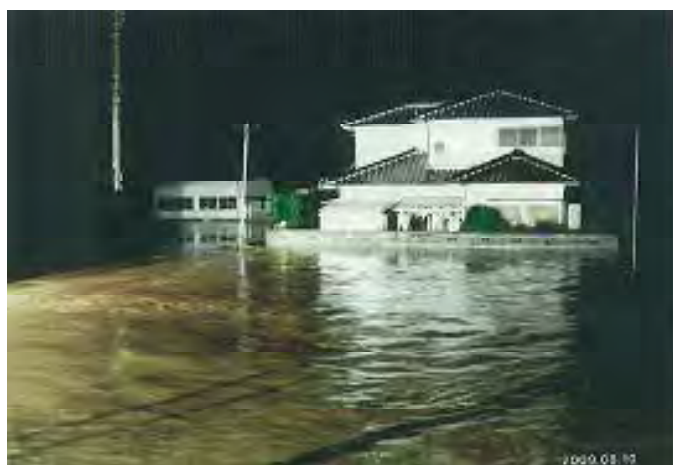
野田橋下流浸水状況(宍粟市山崎町)
