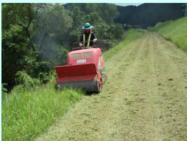
堤防点検(除草作業)の様子
