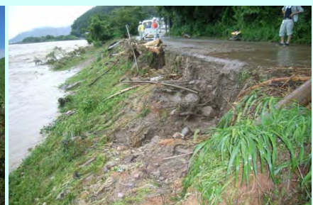
出水後の緊急点検
