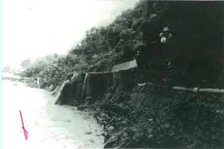
揖保川の氾濫で流出した県道6号(一宮町曲里付近)
