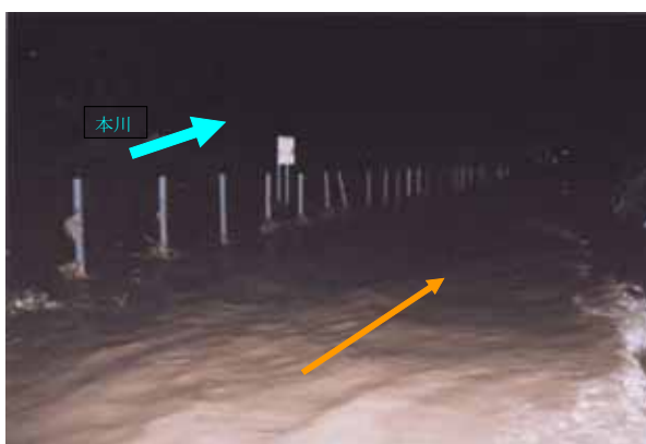
穴栗橋上流無堤地区
