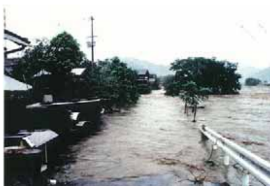
宍粟橋右岸浸水状況
