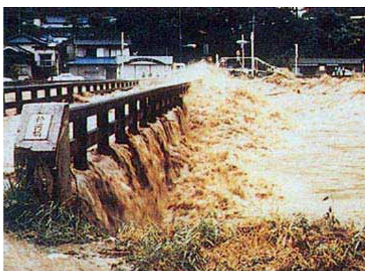
流失前の かみかわ 神河橋
