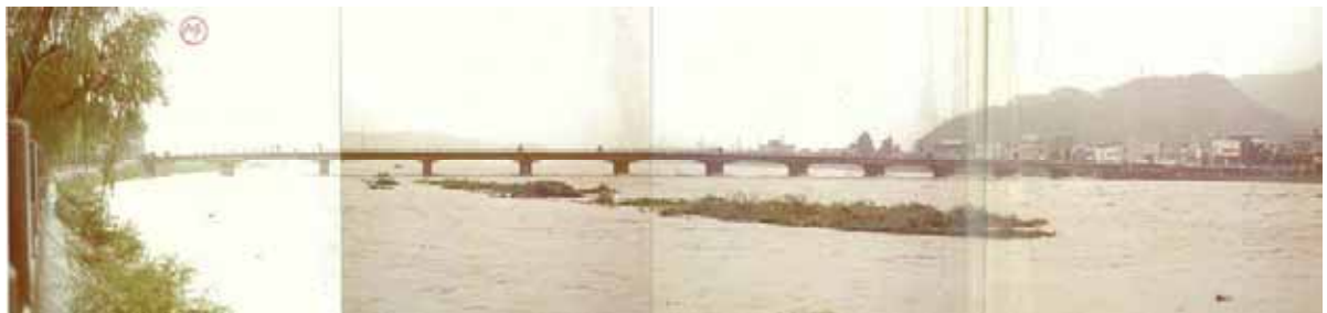
洪水中の龍野橋の状況
