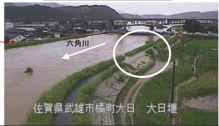
③ 8/14 6:40 六角川29k000付近 武雄市橋町大日付近(越水状況)
