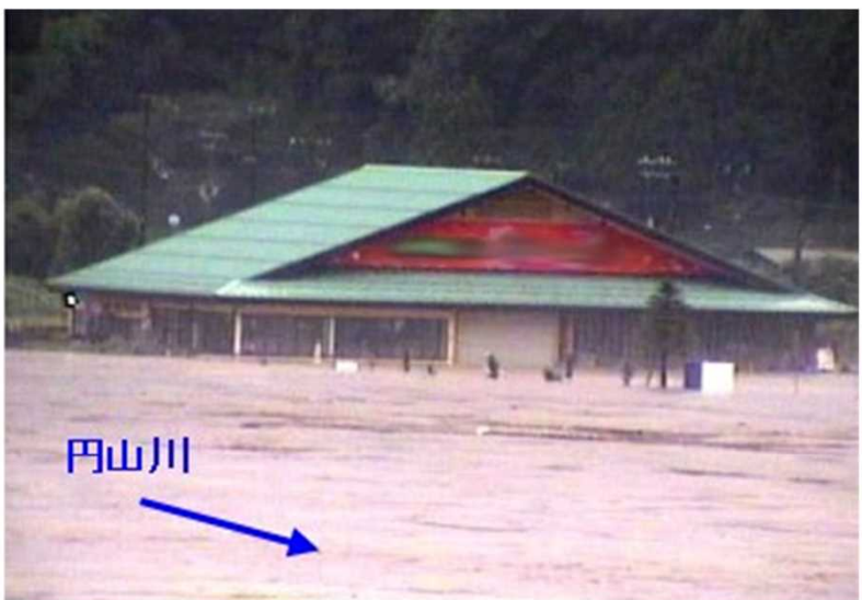
ひのそ地区(円山川左岸6.6k付近)
