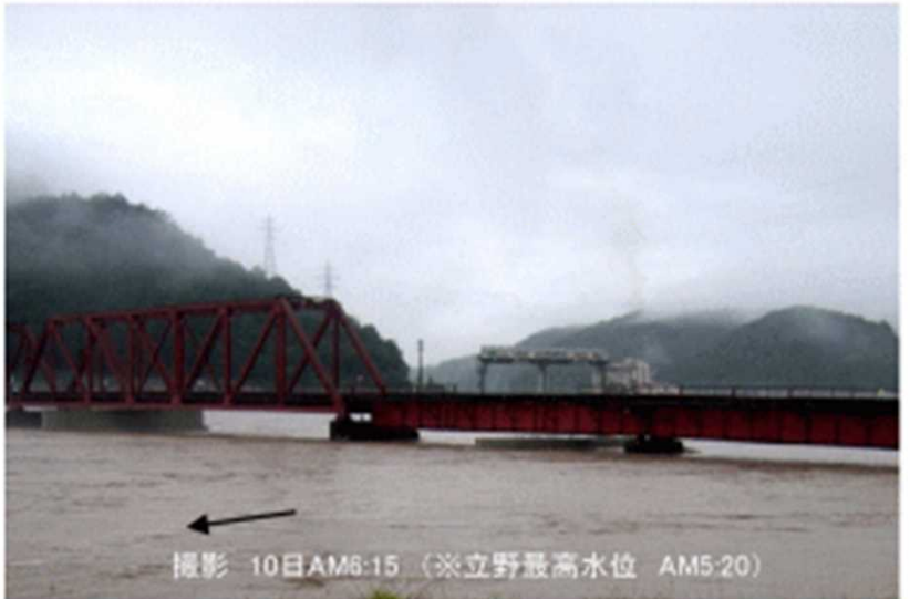
豊岡市 北近畿タンゴ鉄道橋梁
