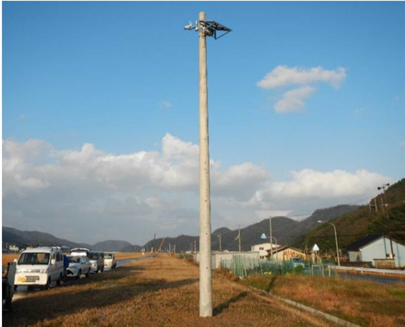
円山川4.10k付近(右岸)戸島地区
