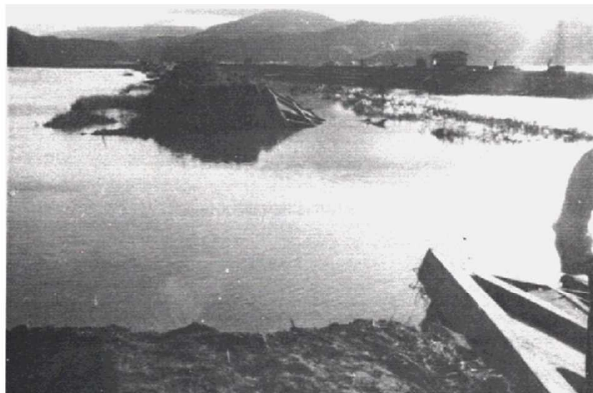
奈佐川(森津) 堤防溢水の状況
