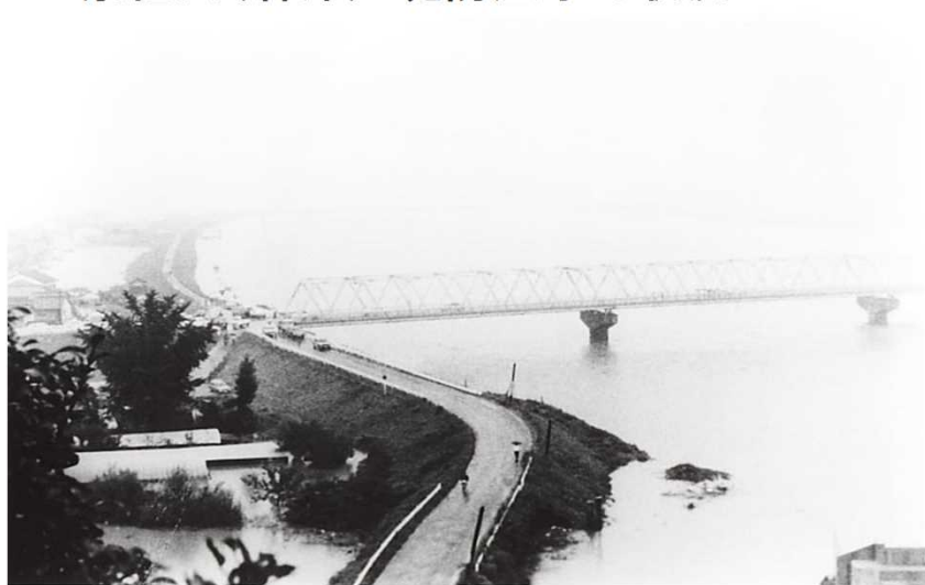
堀川橋付近の状況
