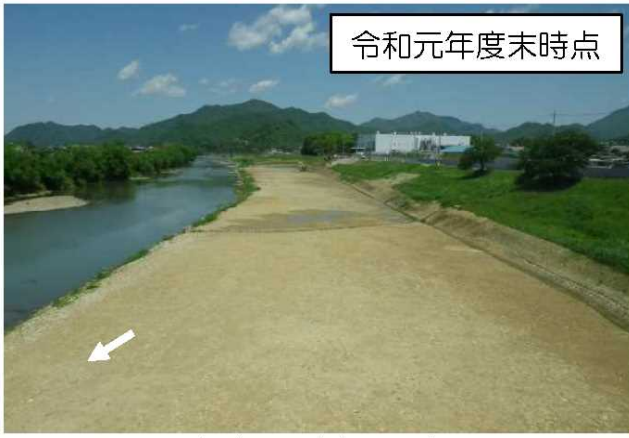
令和元年度末時点 加古川河床掘削工事 (西脇市・県管理区間)
