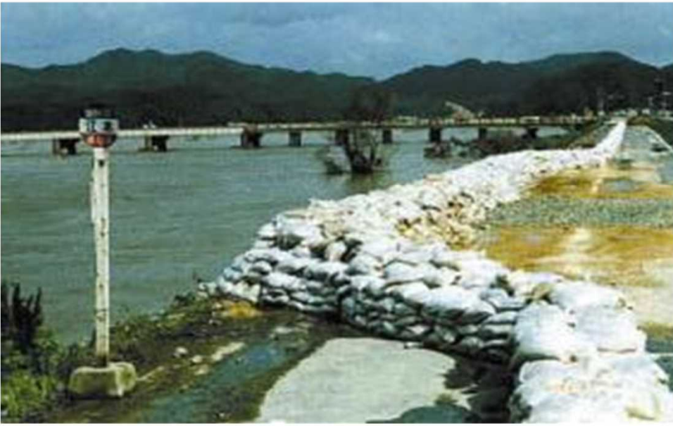
土のう積み 円山川右岸(豊岡市江本)
