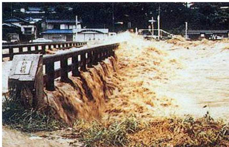
流失前の神河橋(宍粟市山崎町)
