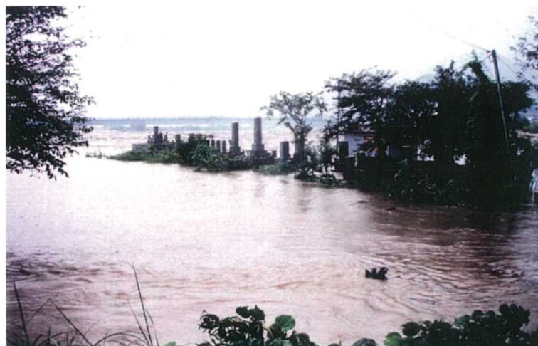
河東大橋南側浸水状況(宍粟市山崎町)
