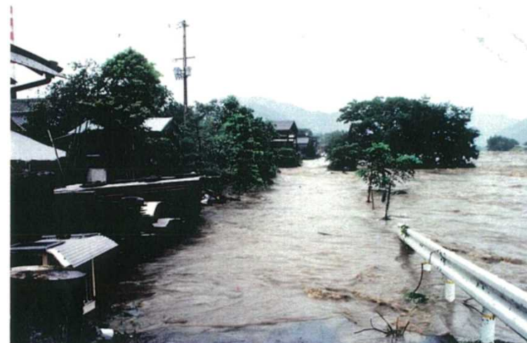
宍粟橋右岸浸水状況(宍粟市山崎町)
