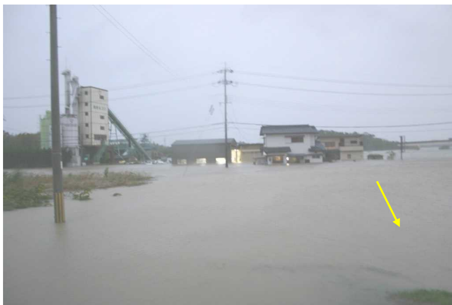
加東市の浸水状況
