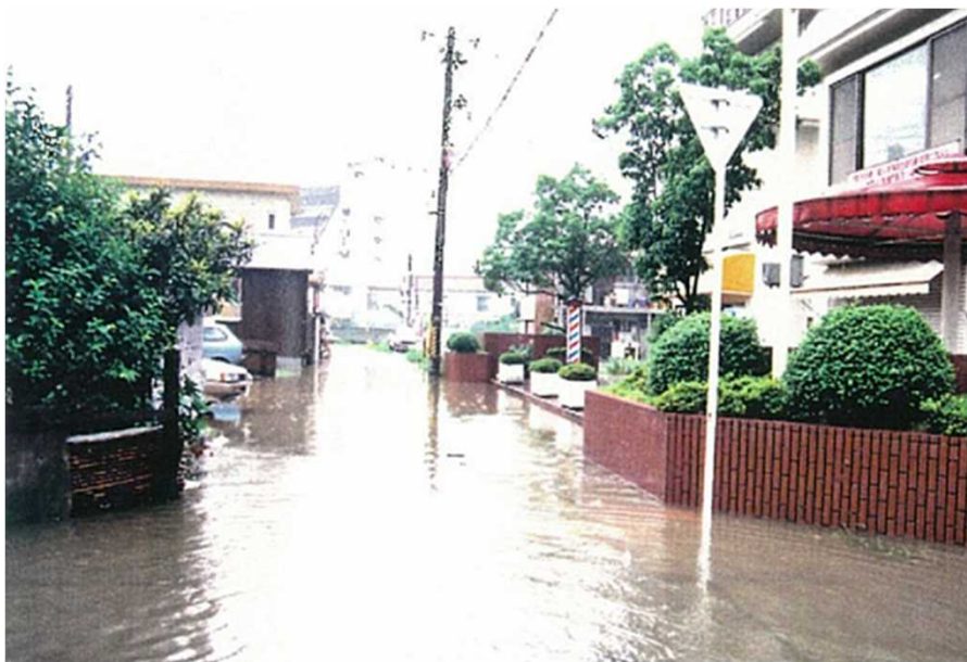
高砂市の浸水状況
