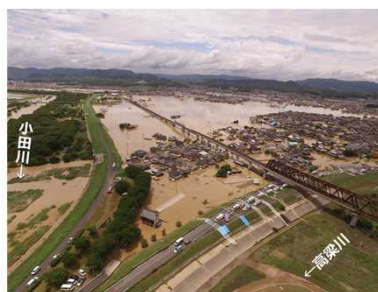
小田川における浸水被害 (岡山県倉敷市)
