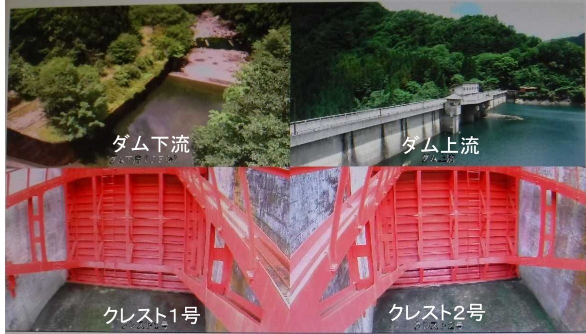
CCTV映像を外部向けへ配信予定(引原ダム)
