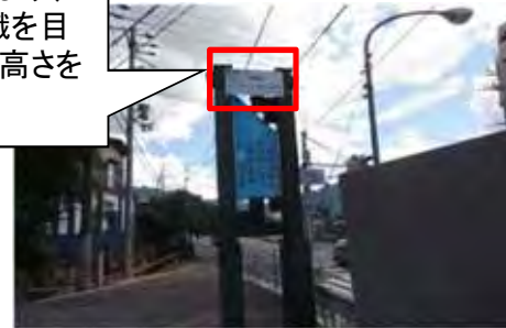
標識設置状況
