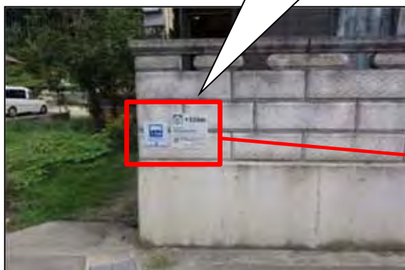
民家の塀に標識を設置
