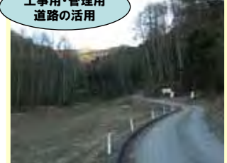
砂防堰堤工事により設置した工事中道路は間伐材の搬出等に活用。
