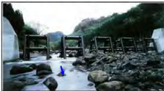
鋼製透過型の砂防えん堤・治山ダムを整備
