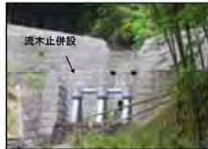
従来の砂防えん堤・治山ダムに流木止を併設
