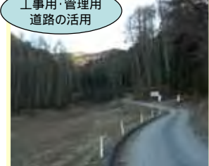
砂防堰堤工事により設置した工事用道路は間伐材の搬出等に活用。
