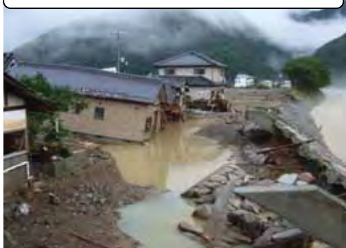
堤防決壊付近の家屋倒壊状況
