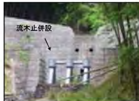
従来の砂防えん堤・治山ダムに流木止を併設
