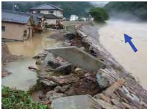
越水による破堤
