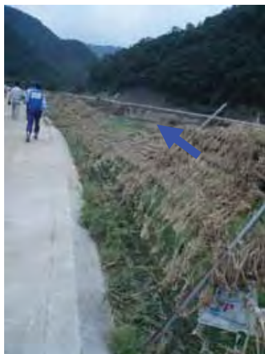
堤内側からの水流によりネットが川側に傾斜
