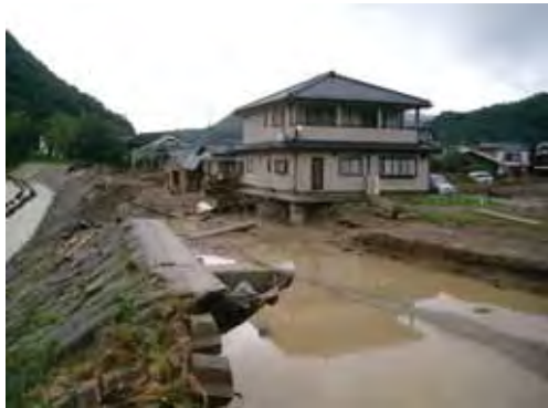
越水による破堤
