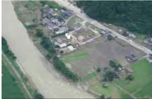
田井地区の浸水状況
