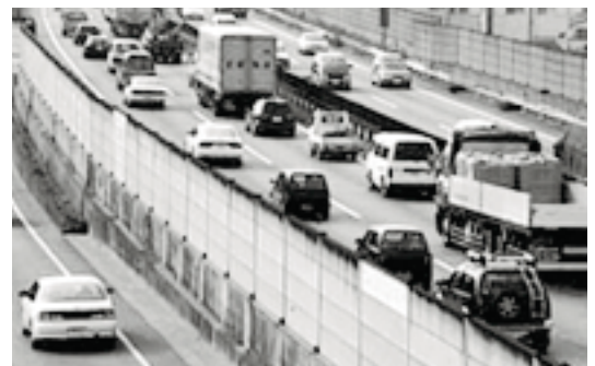
遮音壁の現況
