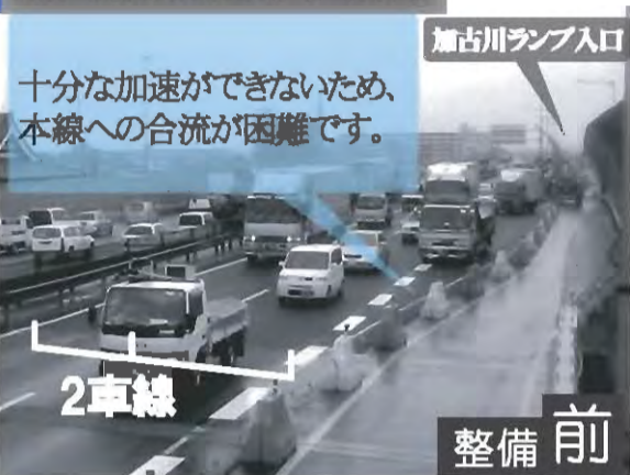
加古川ランプ入口合流部
