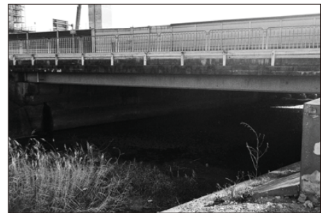
架け替え前の間形橋（北側の側道橋）
