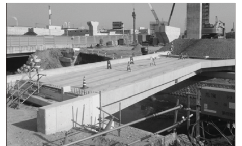
南側の新設側道橋の架設状況
