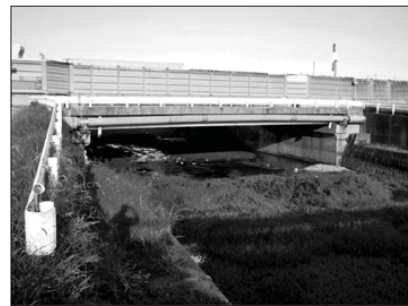
架け替え前の間形橋（南側の側道橋）
