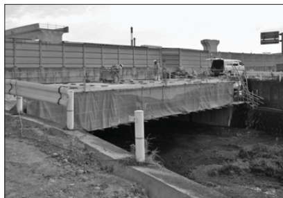
南側の側道橋 撤去状況（上部工撤去中）
