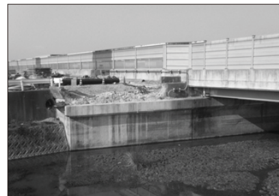
南側の側道橋 撤去状況（上部工撤去完了）
