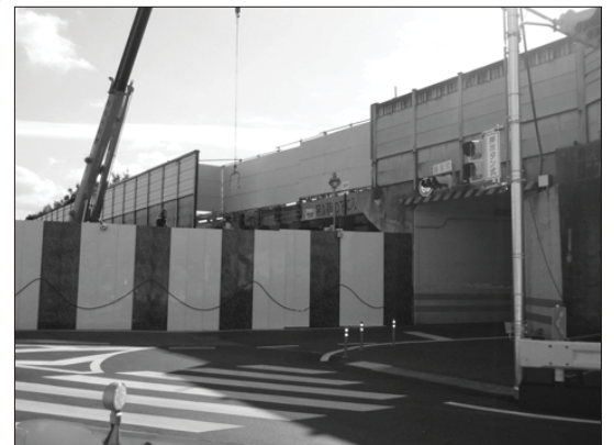
北側側道の工事状況
