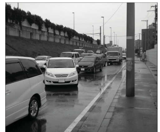
改良前 出口レーンと側道の並行区間（車線変更が困難な状況）
