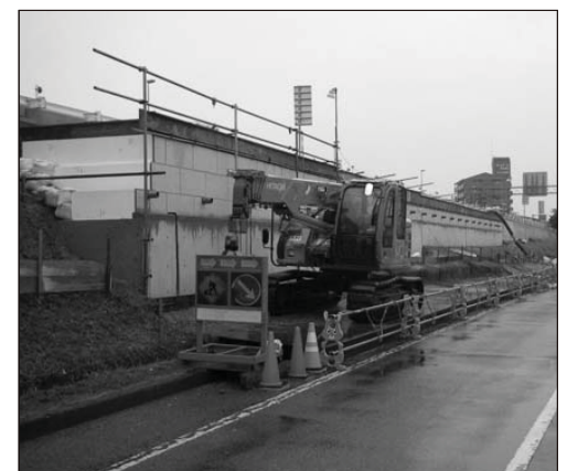
出口レーンの拡幅の工事状況（2車線化）
