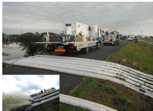
排水ポンプ車による排水作業
