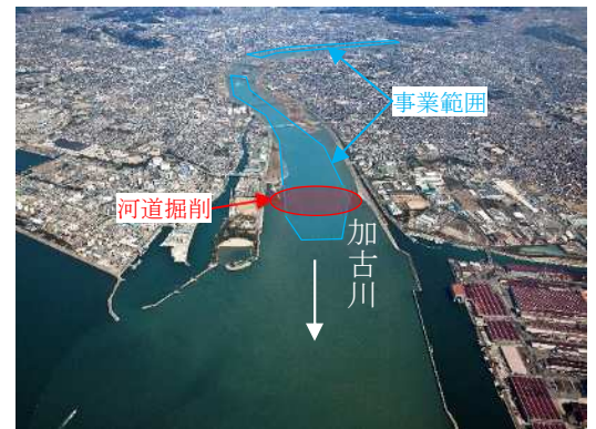
河道掘削箇所 (高砂他地区)
