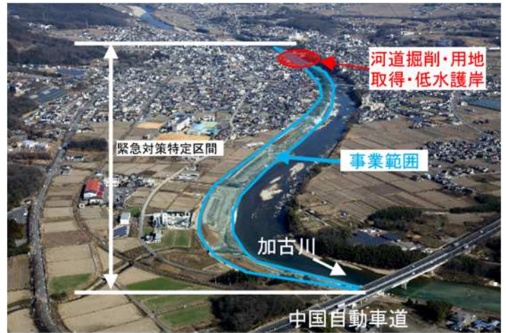
河道掘削・築堤箇所 （滝野地区）
