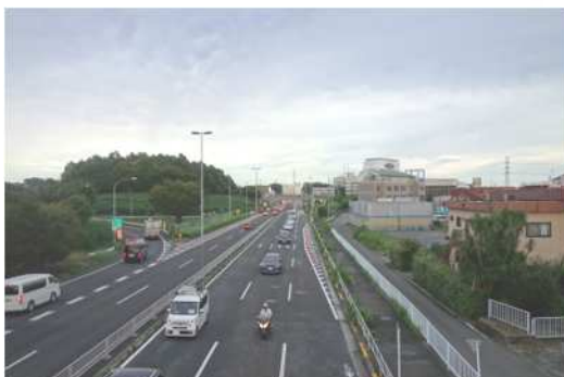
姫路バイパス 舗装補修後
