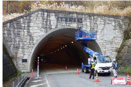
トンネル点検状況
