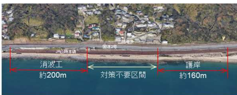
護岸整備等箇所(神戸市垂水工区塩屋東地区)
