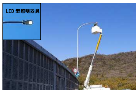
LED 型照明器具の取替工事
