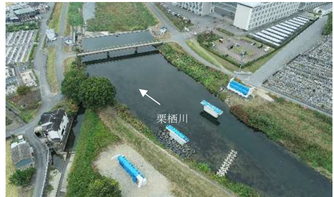
橋梁架替実施状況(新宮地区)(令和6年1月時点)
