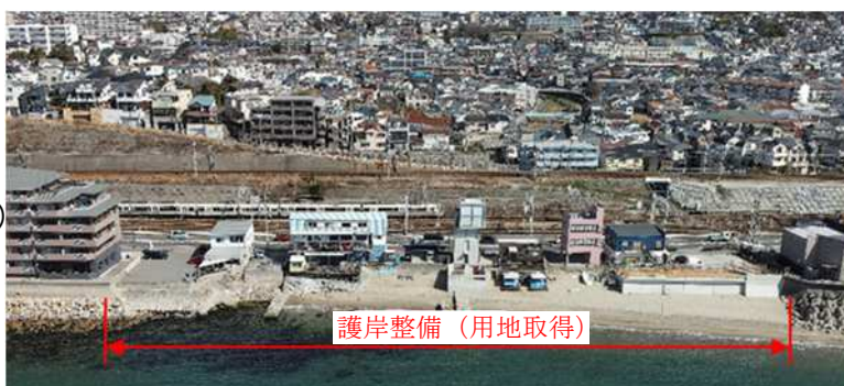
護岸整備等箇所(神戸市垂水工区狩口地区)
