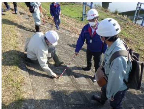
堤防点検(護岸調査)
