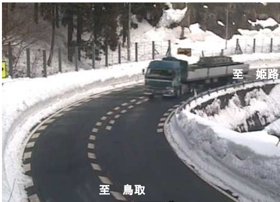
線形不良箇所 (宍粟市波賀町戸倉地先)
