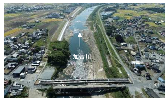
築堤等実施状況(大門地区)(令和6年1月時点)
