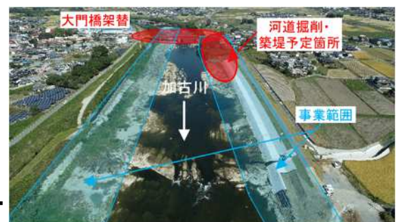
河道掘削・築堤・橋梁架替箇所 (大門地区)
