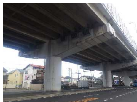
橋梁の耐震補強工事(曾根高架橋)
