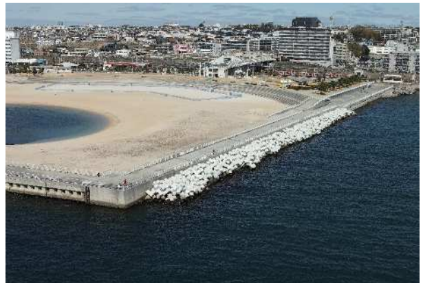
大蔵海岸消波ブロック高上げ(明石東部工区)
