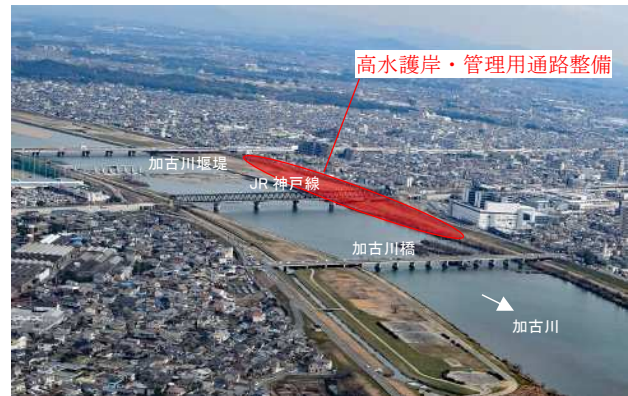
整備箇所(加古川 5.6k~6.4k 左岸付近)
