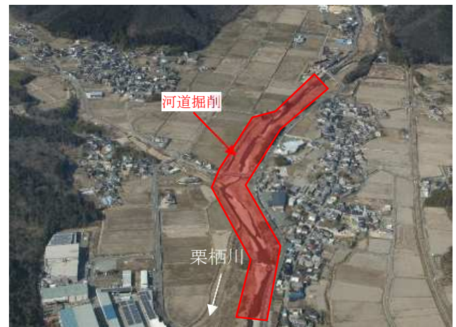
河道掘削予定箇所状況(大屋地区)(令和5年3月時点)
