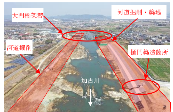
河道掘削・築堤・樋門築造・橋梁架替箇所 (大門地区)
