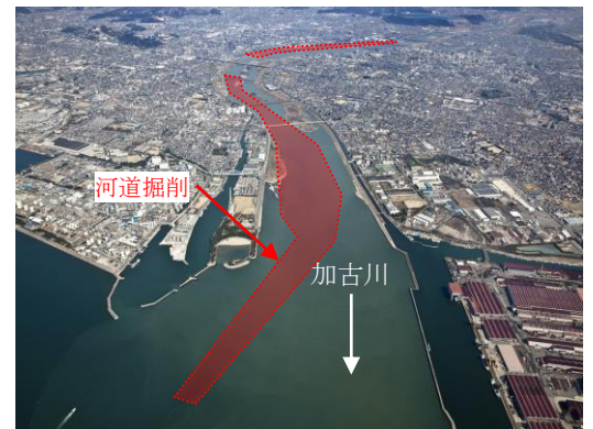
河道掘削箇所 (高砂他地区)
