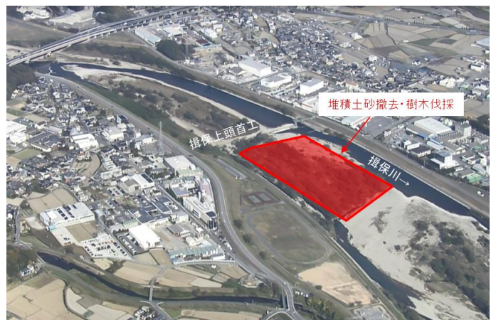
堆積土砂撤去実施箇所(大道・山下・半田地区)
