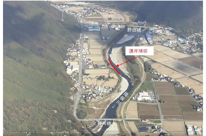
護岸補修実施箇所(田井地区)
