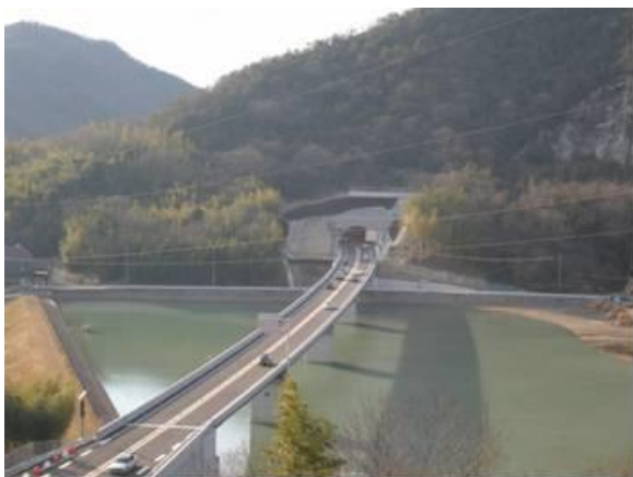
姫路北バイパス(姫路市石倉地先) いしくら
