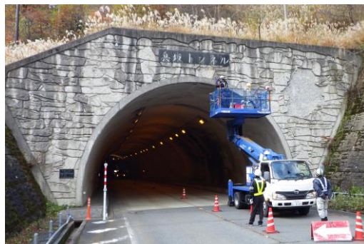
トンネル点検状況
