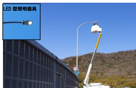
LED 型照明器具の取替工事
