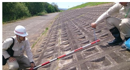
堤防点検(護岸調査)
