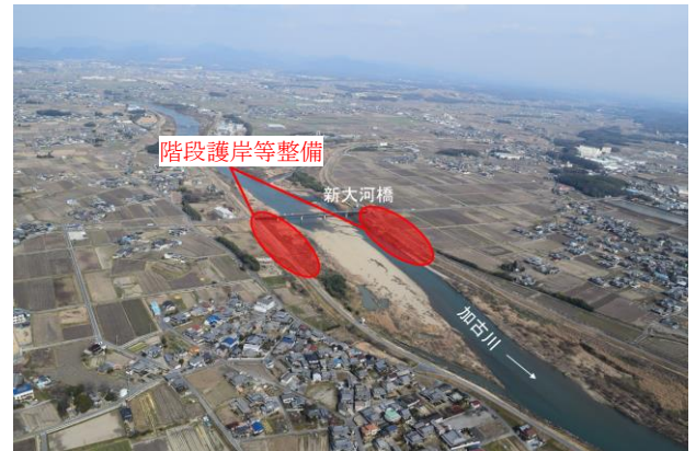
整備箇所(加古川 24.6k~25.0k 付近)
