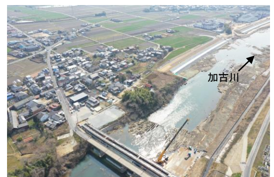
築堤等実施状況(大門地区)(令和5年3月時点)
