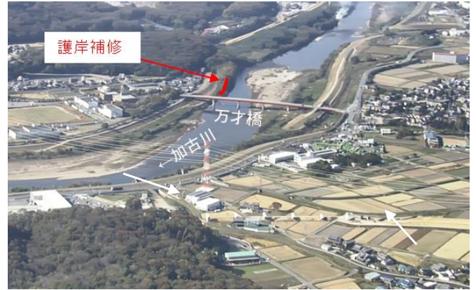
護岸補修実施箇所(黍田地区)
