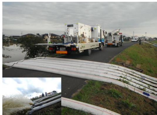
排水ポンプ車による排水作業
