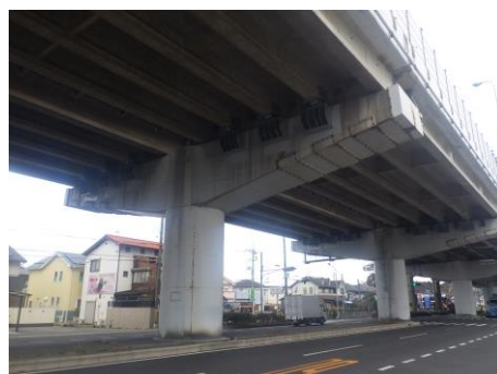
橋梁の耐震補強工事(曾根高架橋)
