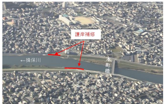
護岸補修実施箇所(興浜地区)
