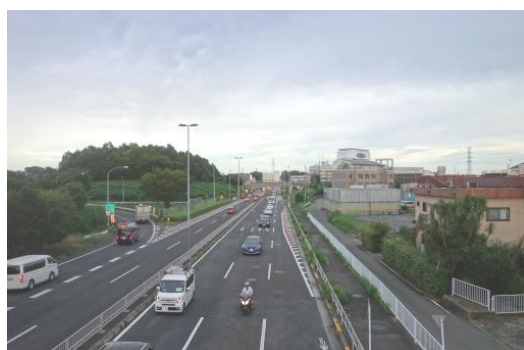
姫路バイパス 舗装補修後
