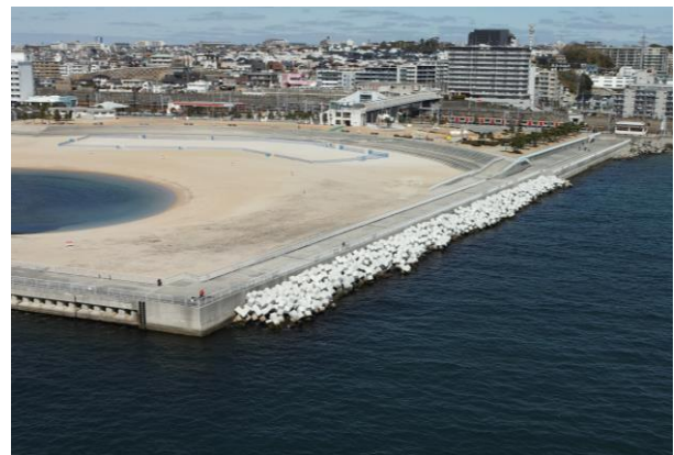
大蔵海岸消波ブロック嵩上げ(明石東部工区)
