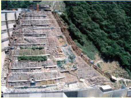
ダム建設中 (H11年8月)
