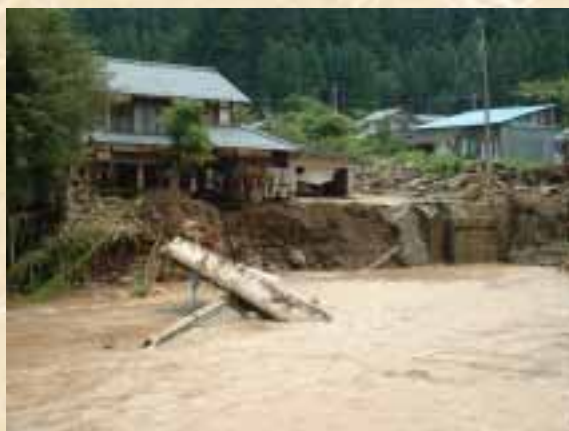
護岸が流出、民家被害 (美山町東河原)
