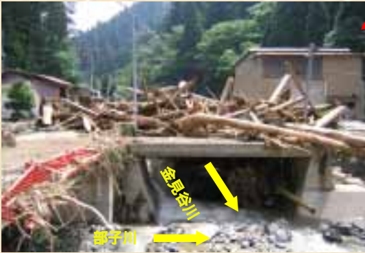
橋にせき止められた流木 (部子川金見谷川合流点)
