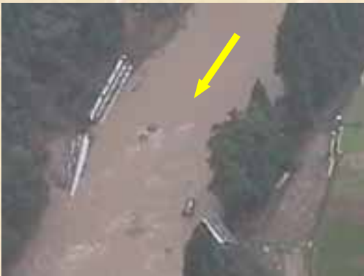
流出倒壊したJR第7足羽川橋(美山町小和清水)
