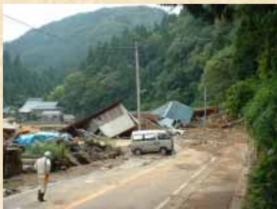
護岸が流出、倒壊した倉庫 (美山町折立)
