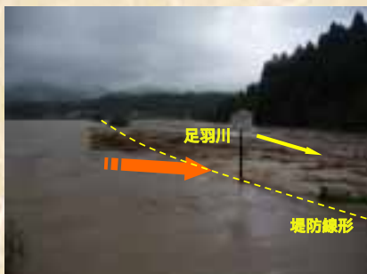
越水した流水が足羽川に戻る (高田大橋上流)
