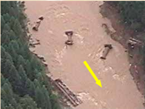
流出倒壊したJR第3足羽川橋(美山町高田)
