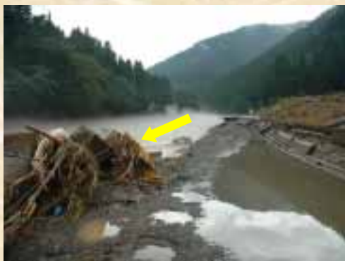
護岸流出し、道路が消失 (美山町西天田)
