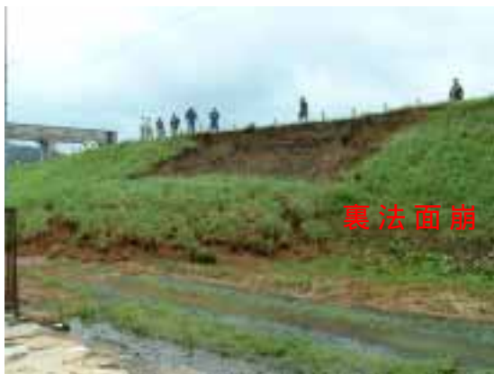
福井市種池町 日野川右岸10.5km付近
