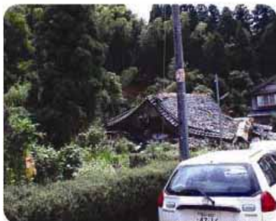
福井市深見町：がけ崩れ：1戸全壊
