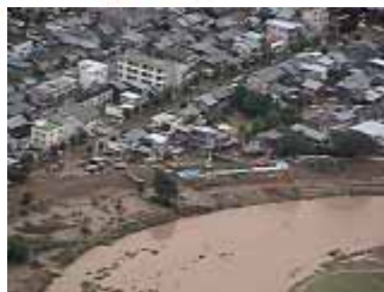
足羽川 破堤箇所状況
