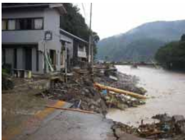
一般国道476号(美山町西河原) 道路流失
