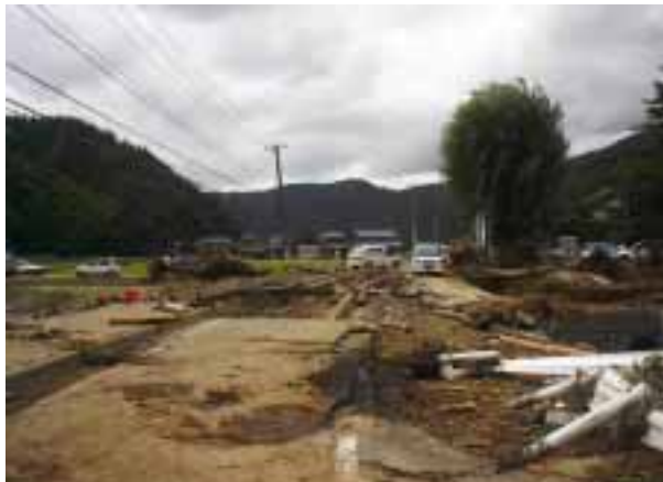
(主) 篠尾勝山線 (美山町安波賀中島) 道路流失
