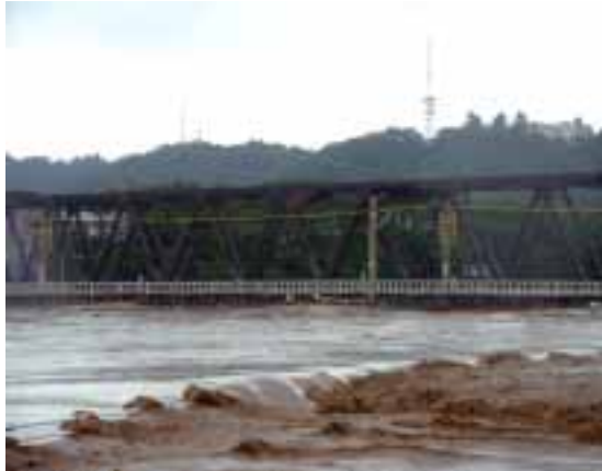
足羽川4.2km付近 JR足羽川橋梁
