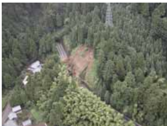
(一) 徳光鯖江線 (鯖江市大正寺町) 法面崩壊
