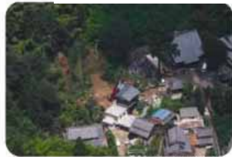
鯖江市大野町：がけ崩れ
