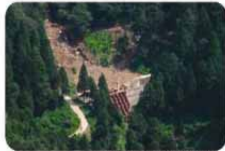
今立町柳：堰堤に補提された土砂と流木
