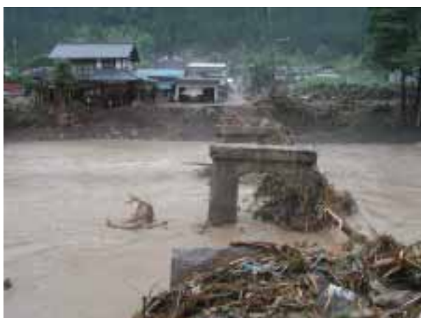
町道東河原線(美山町西河原地係) 落橋 橋梁名 田尻新橋
