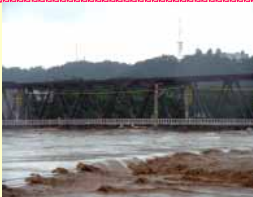
足羽川4.2km付近 JR足羽川橋梁
