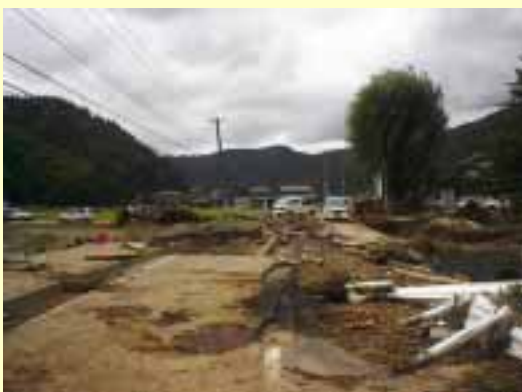
(主) 篠尾勝山線 (福井市安波賀中島) 道路流失
