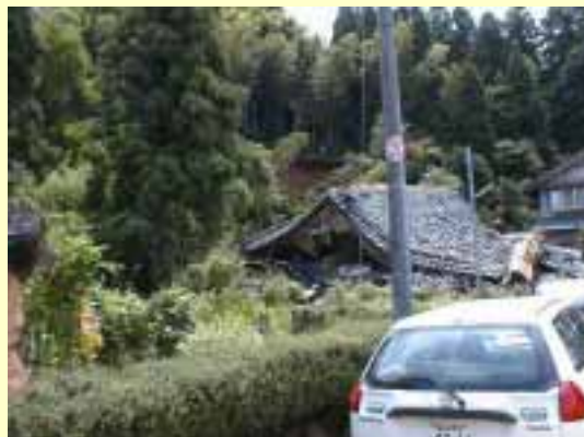
㉓ 福井市深見町 : がけ崩れ
