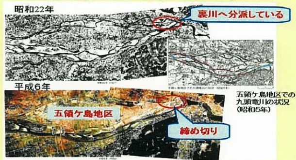
図2.6 五領ヶ島裏川締め切り
