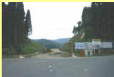
武生市広瀬町地係 起点側
