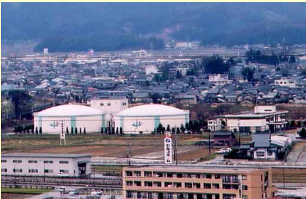
鯖江市上水道管理センター
