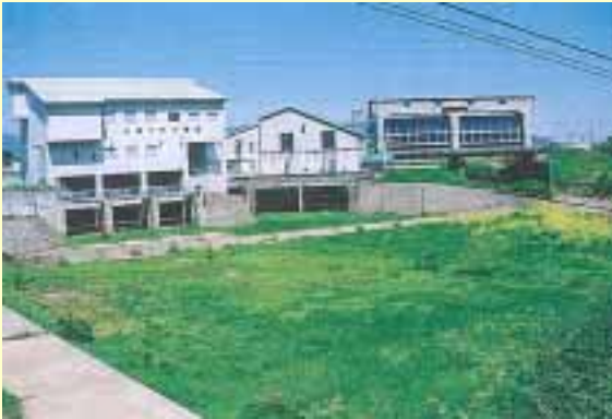
江端川排水機場と樋門
