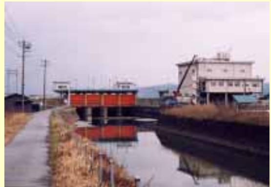
黒津川排水機場と樋門
