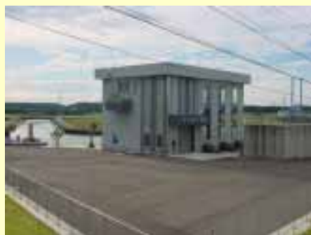
片川排水機場
