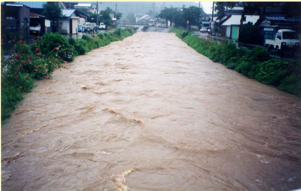
赤根川流域【大野市清滝付近】 平成7年7月 出水
