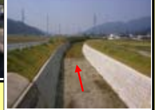
コンクリートブロック積み護岸 (南河内川)
