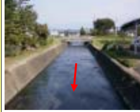
コンクリートブロック積み護岸 (木爪川)
