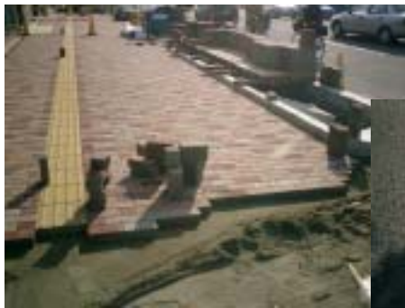
透水性コンクリート ブロック舗装
