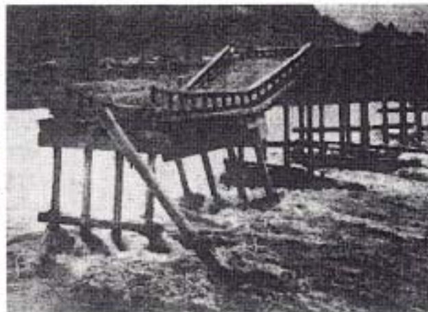
昭和39年7月出水 一部流出した里沙門橋 （S39.7.10付朝日新聞より）
