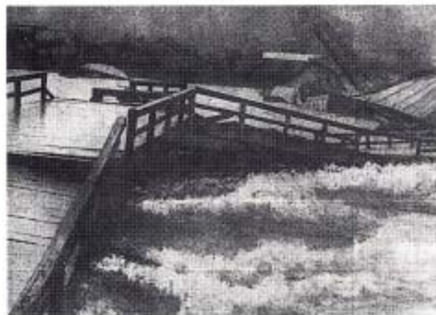
昭和34年8月出水 激流で流出する桜橋 （S34.8.14付福井新聞より）
