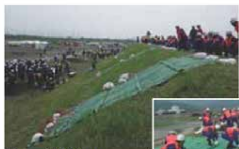
シート張り工
