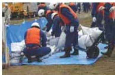
改良積土のう工
