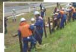
杭打ち積土のう工
