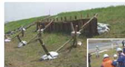
杭打ち積土のう工
