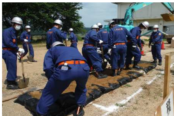
②積土のう訓練
