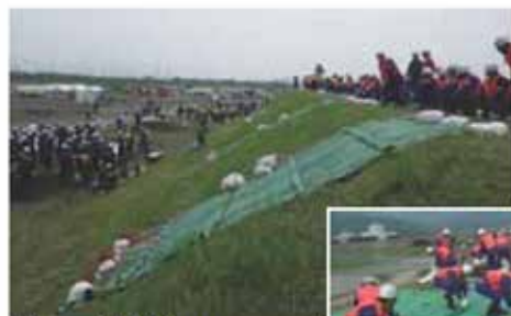
シート張り工
