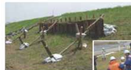
杭打ち積土のう工
