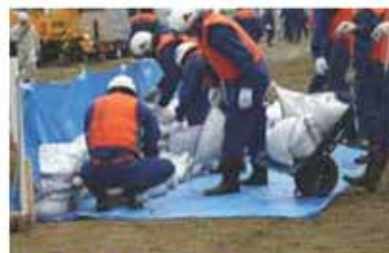
改良積土のう工
