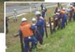
杭打ち積土のう工
