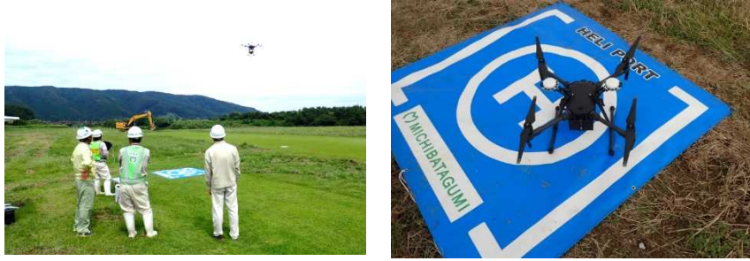
ドローンによる3次元着工前測量
