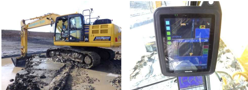
MCバックホウによる施工
