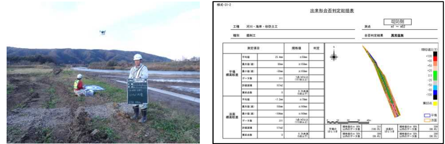
UAV出来形測量
